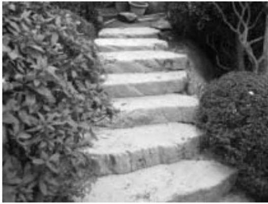
道路から玄関までの高低差、約2mのところを伊予青石の踏み込み石を使用し(約1000×500×150mm)アプローチとして階段状に施工いたしました。お施主様と一緒に施工し、ご要望にあった商品を提供できました。 [伊藤慎志]
